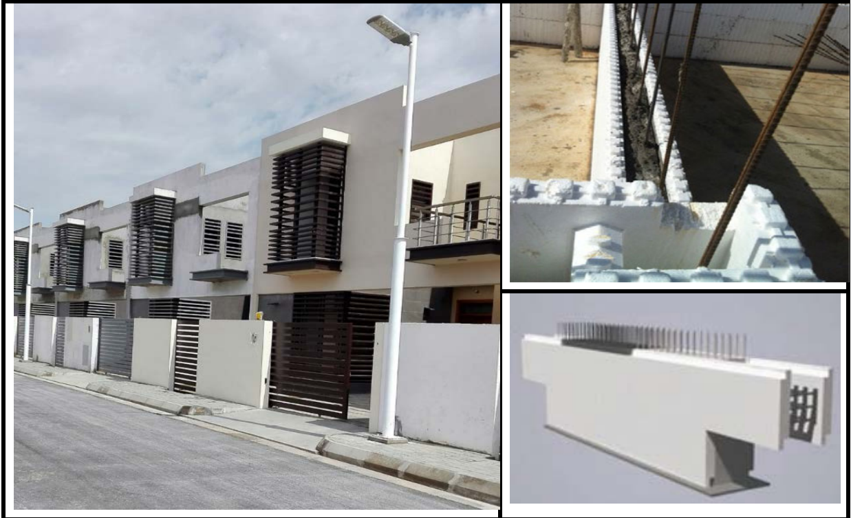
شكل (4) تقنية "ICF" لإنتاج الوحدات السكنية في مجمع السلطان السكني في النجف/المصدر: الباحثة من زيارة موقعية للمشروع
