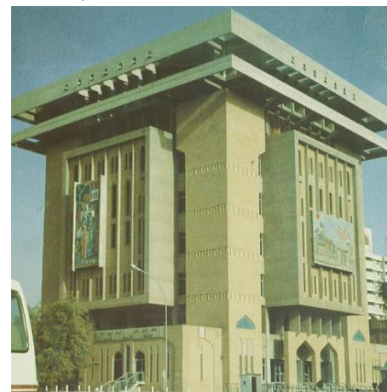
شكل (5) مبنى المصرف العقاري
