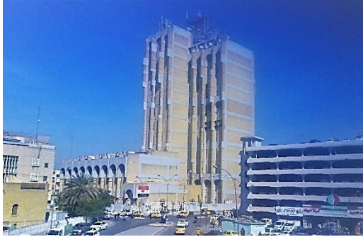
شكل (5) مبنى البريد والاتصالات ، مصدر الصورة الباحثان
