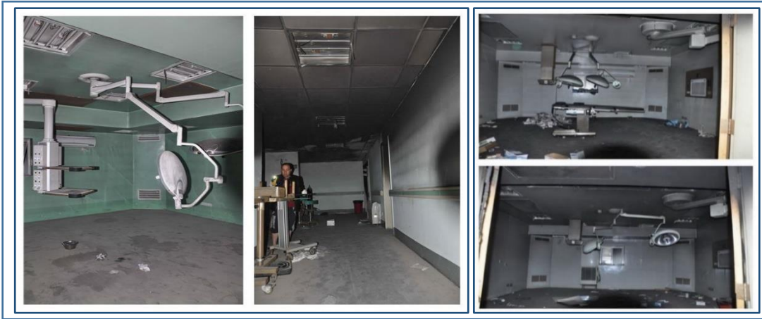
الشكل رقم (12) يوضح الاضرار التي اصابته مبنى مستشفى الفلوجة التعليمي على مستوى الجزء (قسم الجراحة). (لمصدر: الباحثان)
